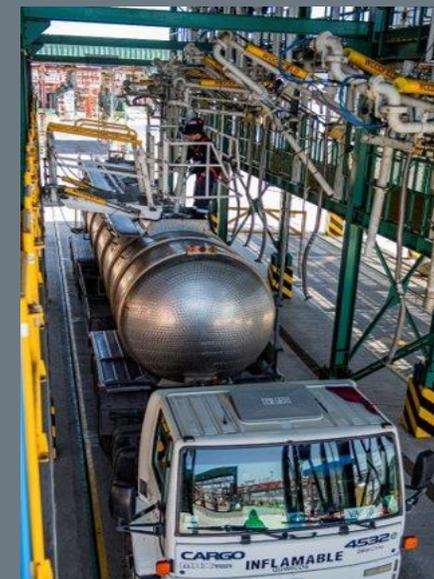
La Isla de Carga posee conos de control de emisión que permiten una carga cerrada, conectados a la VRU si es gasolina (recuperación) o a la RTO si es un Químico (eliminación).
